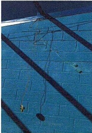
FOTO 1: Cambio del sistema eléctrico de módulos 1,2,3,4 y cocina.
