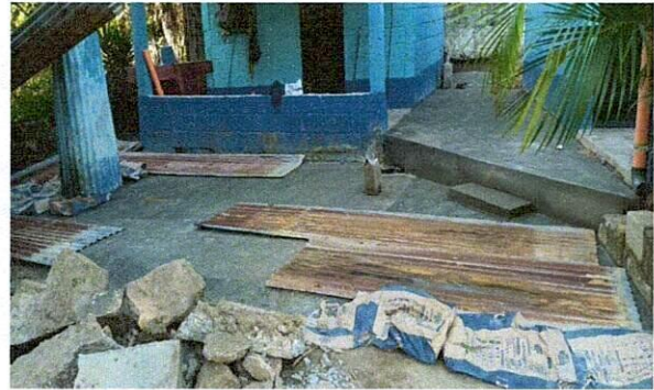
FOTO 2: Cambio de cubierta con lámina troquelada calibre 26, pintura, mejoramiento de puerta, balcón y cambio de ventanas
